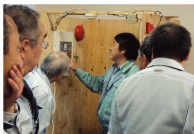
パネルで施工実習
